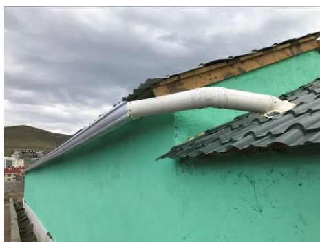
Photos 8 et 9 – Système de collecte des eaux de pluie
