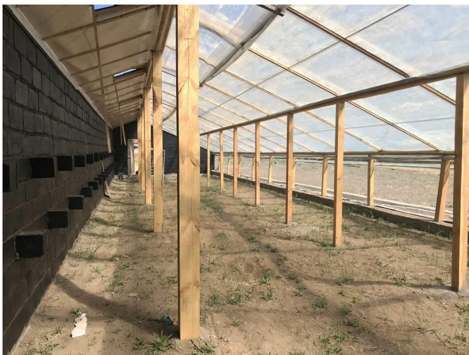
Photo 10 – Vue intérieure de la serre avant la préparation du sol
