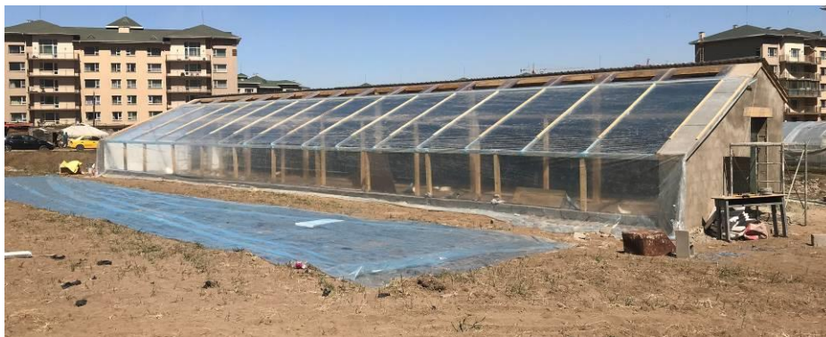
Photo 7 – Pose des bâches horticoles
