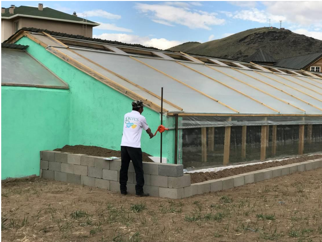
Photo 11 – Ouverture des ouvrants inférieurs
