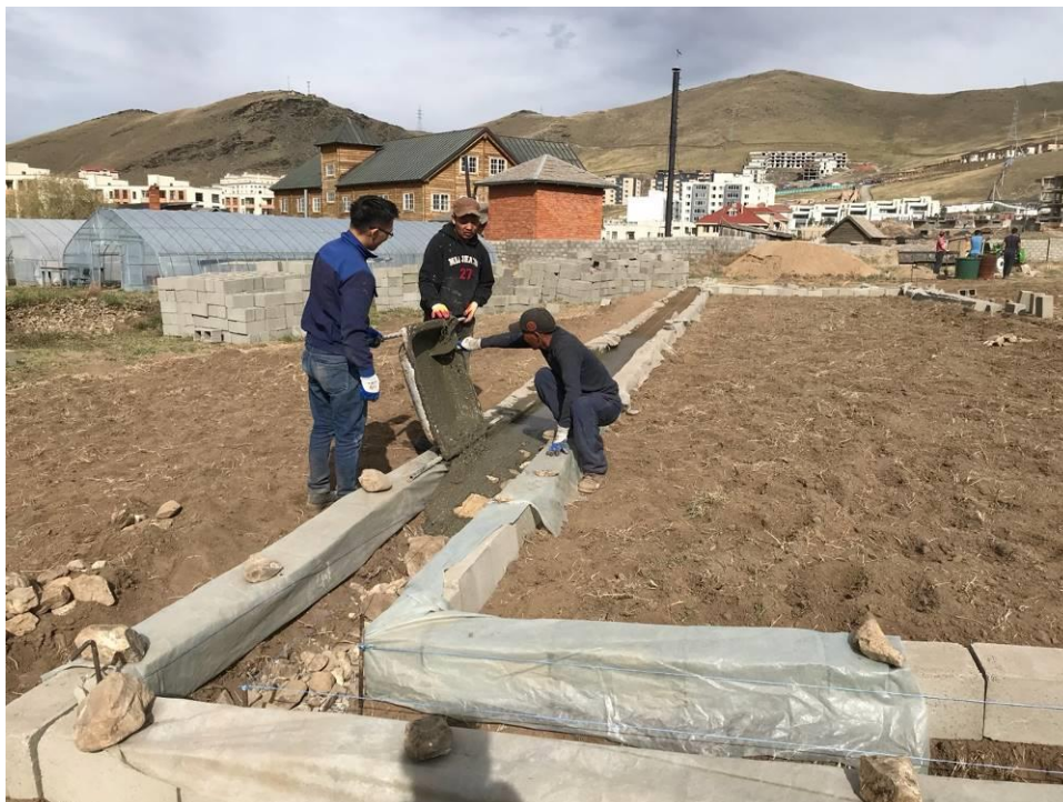
Photo 5 – Coulage des fondations de la SSP
