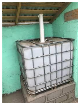
Photos 8 et 9 – Système de collecte des eaux de pluie
