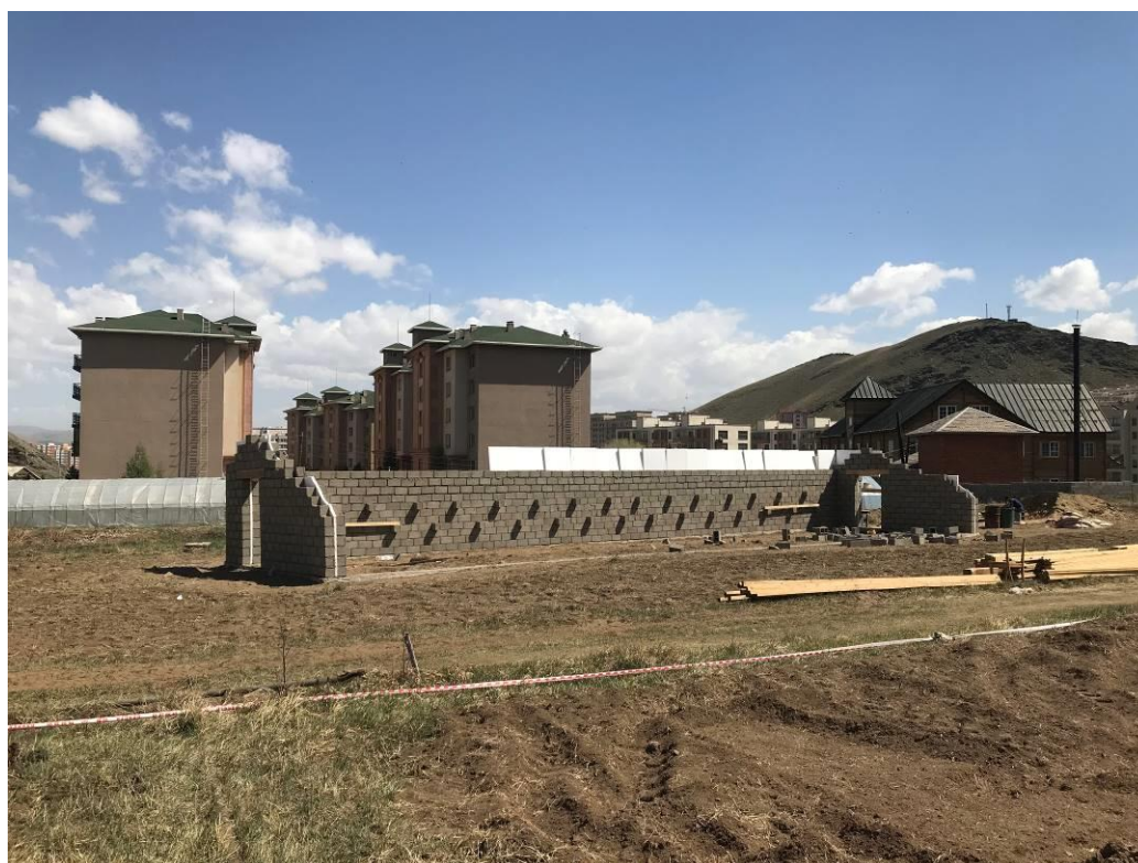
Photo 6 – Construction des murs
