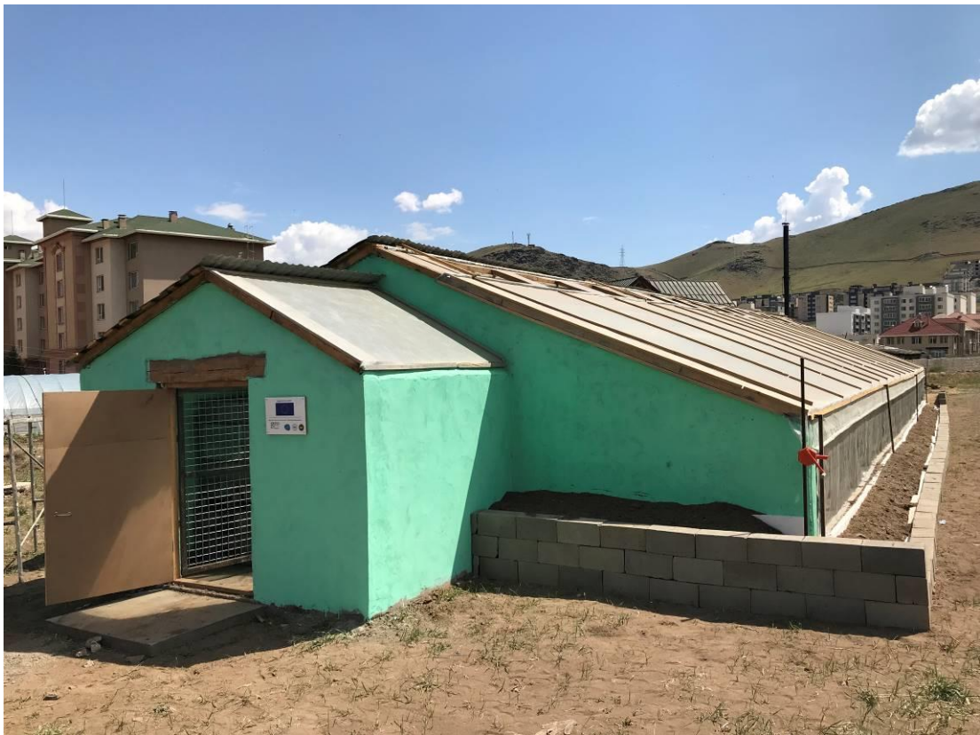
Photo 12 – Remplissage des murets d'isolation extérieurs
