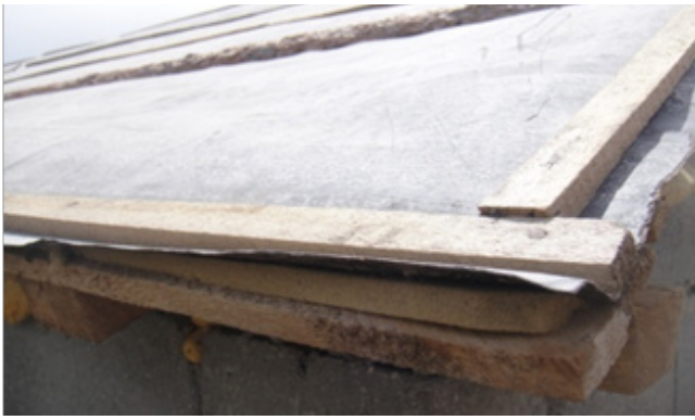
(I) Дээврийн хар цаас болон хар цаасан доорх нимгэн порлонон зөөлөвч
