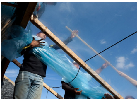
Зураг 23 : Гадна талын плёнк татаж байгаа нь
