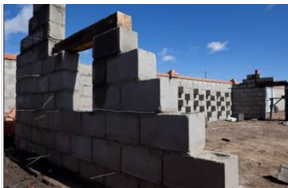
(B) Өрлөгийн төмөр, цонхны ялу суулгасан блокон хана
