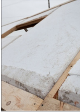
(K) Хана болон дээврийн хөөсөнцөрийн залгаас (зүүн) Плёнк даруулж хадахад жийрэглэсэн зөөлөвч(баруун)
