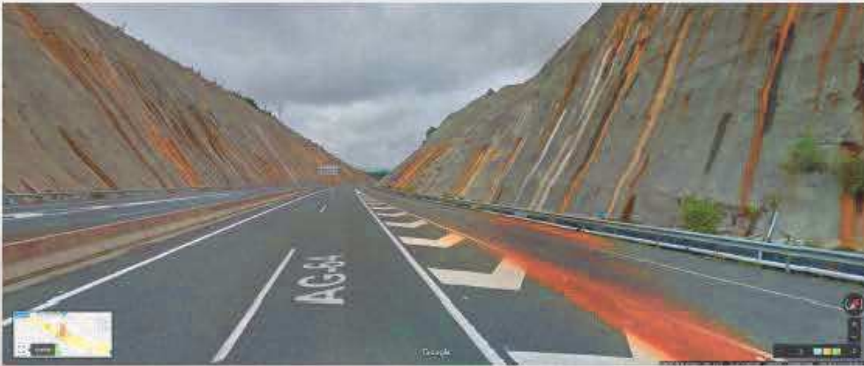
Fig. 2. Trinchera de "Os Airios" (Fuente: Google Street View).
